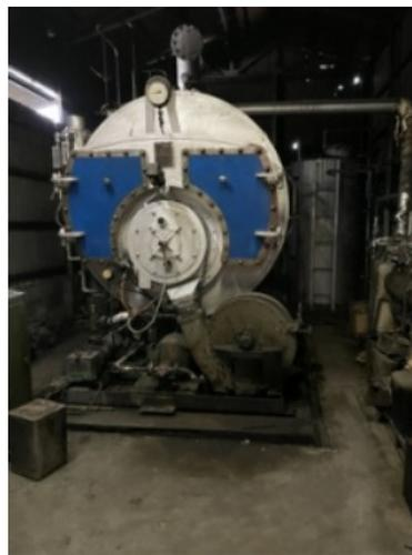
度の蒸気を作っているそうです。糸の塊(チーズ)を圧力のかけられる釜に入れて、ボイラーで作られた130度の蒸気と高い圧力を掛けて2時間程で糸が染まるそうです。
